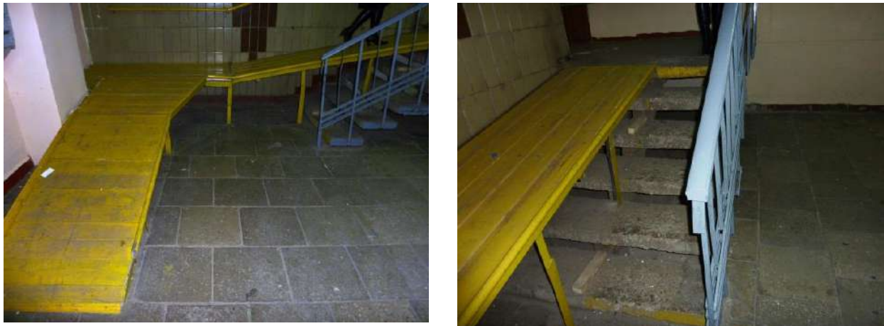
Рисунок 6.2.14 – Пандус в габаритах вестибюля жилого дома
