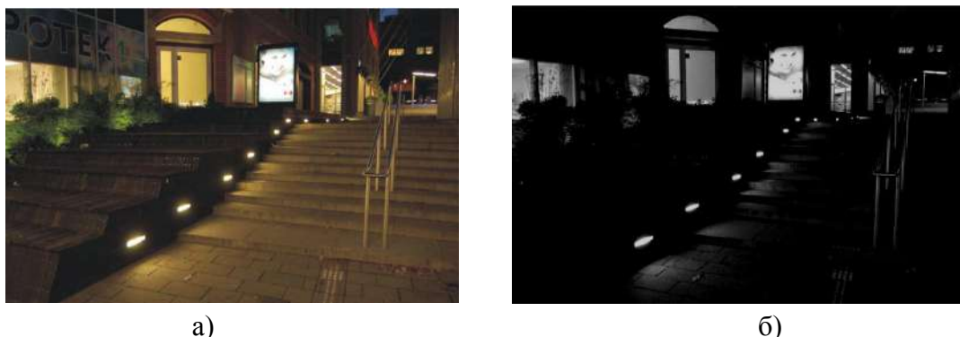
Рисунок 76 – Пример бокового освещения и обустройства лестниц, доступных для инвалидов по зрению: цветное (а) и хроматическое (б) изображения
