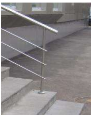
Рисунок 6.1.14 – Недопустимые варианты окончаний поручней
