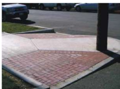
Рисунок 22 – Пример пандусов с бортиками
