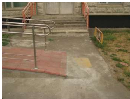
Рисунок 6.1.26 – Опасная зона перед спуском пандуса
