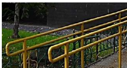
Рисунок 6.1.21 – Недопустимые конструкции креплений поручней на пандусе
