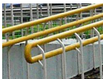
Рисунок 6.1.21 – Недопустимые конструкции креплений поручней на пандусе
