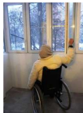
Низкое расположение оконной фурнитуры
