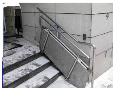
Рисунок 6.1.19 – Откидной пандус на внешней лестнице
