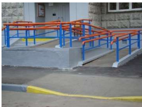
Рисунок 6.1.26 – Опасная зона перед спуском пандуса
