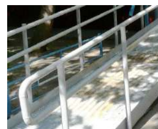
Рисунок 6.1.21 – Недопустимые конструкции креплений поручней на пандусе
